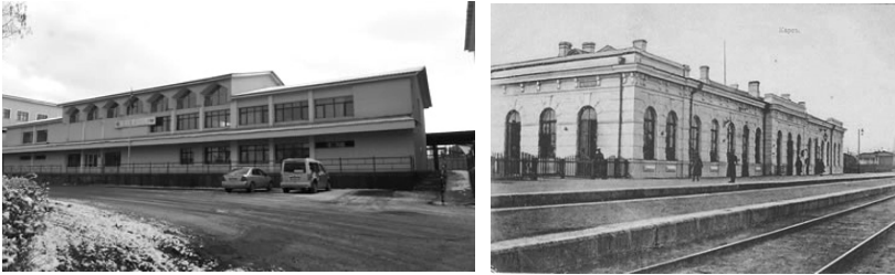
Resim 8. Eski gar binası ve 1970'de yapılan betonarme gar binası
