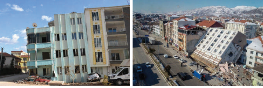
Şekil 43. Zemin sıvılaşması nedeniyle hasar almış binalar
