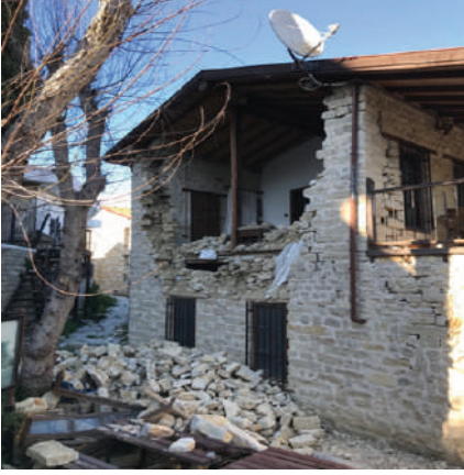
Hatay, Samandağ Vakıflı Köyü'nde düzlem dışı hasarlara örnek; Antakya, Kurtuluş Caddesinde düzlem dışı hasarlara örnek
