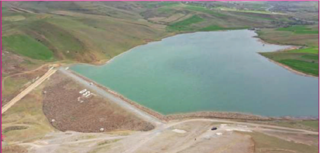
Şekil 19- Polat Barajı dolgu ve rezervuarından bir görünüm
