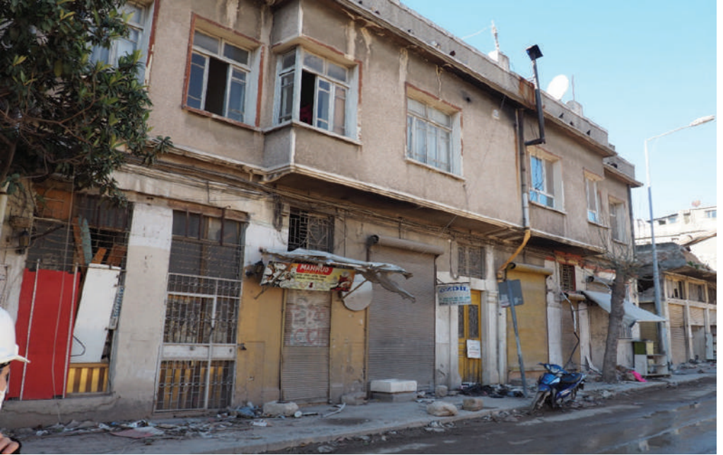
Kurtuluş Caddesi, olasılıkla 1930-40'lı yıllara tarihlenen yığma tuğla duvarlı, betonarme döşemeli yapı
