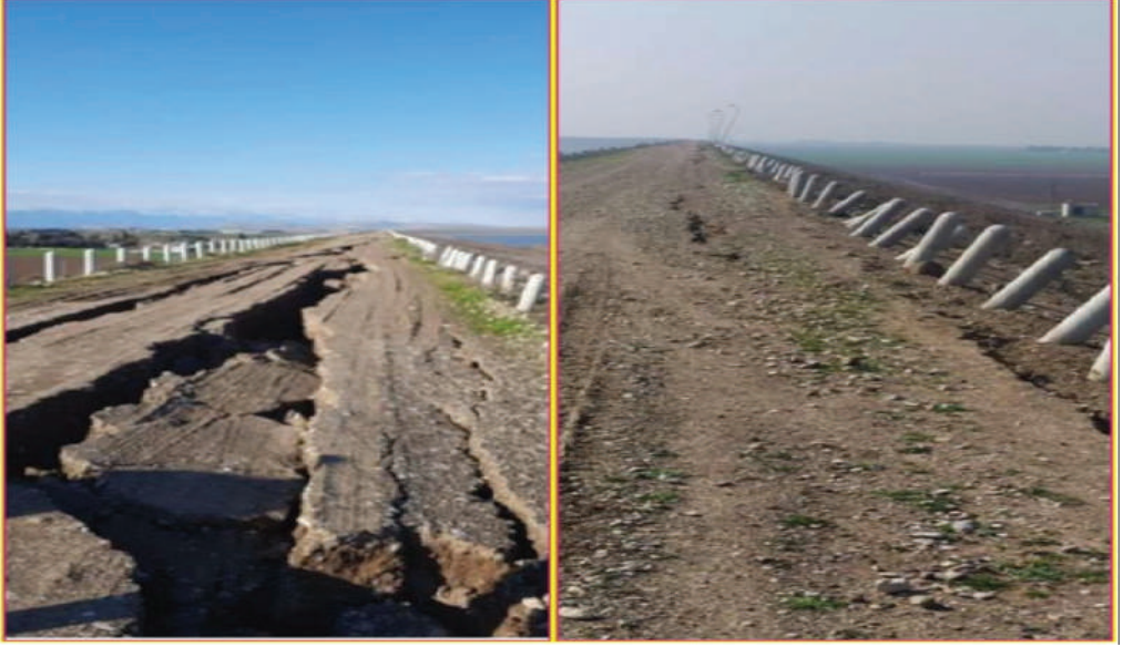
Şekil 42- Reyhanlı Barajı dolgusundan görünümler
