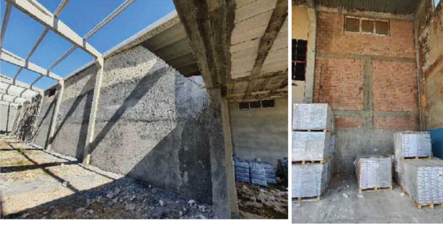
Cephe duvarlarında yatay/düşey hatılların önemi
