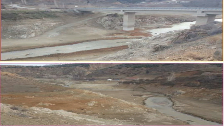
Şekil 25- Kandil Barajı ve Elbistan deprem merkez üssü arasında akan deredeki suyun bulanıklığı
