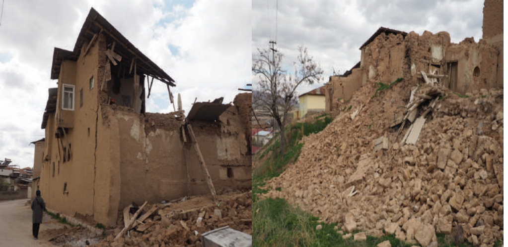
Balaban 2023 Deprem sonrası yıkılmış yapılar
