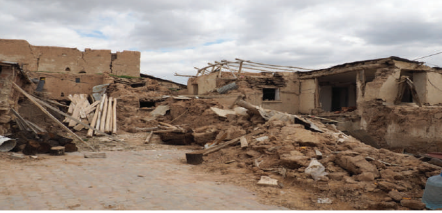
Balaban Ağır hasarlı kerpiç yapılar. Kullanıcılar, yıkılan yapıların ahşap kirişlerini toplayarak tekrar kullanmak ya da satmak için kenara diziyor.
