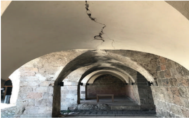
Payas, Sokullu Mehmet Paşa Kervansarayı kuzey revağı
