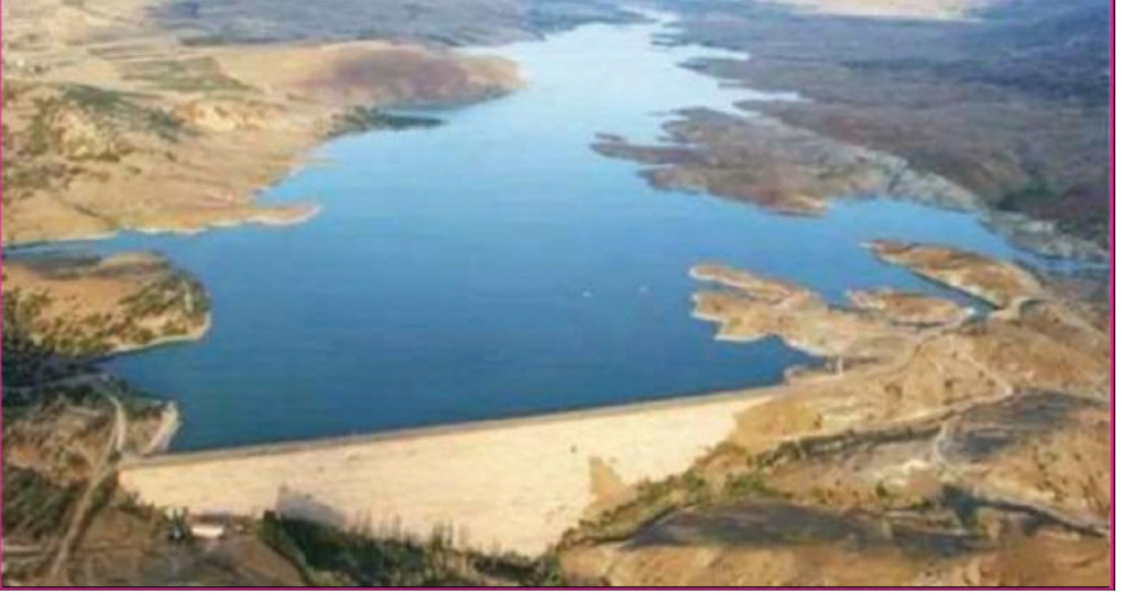
Şekil 9- Sürgü barajı dolgusu ve rezervuarı
