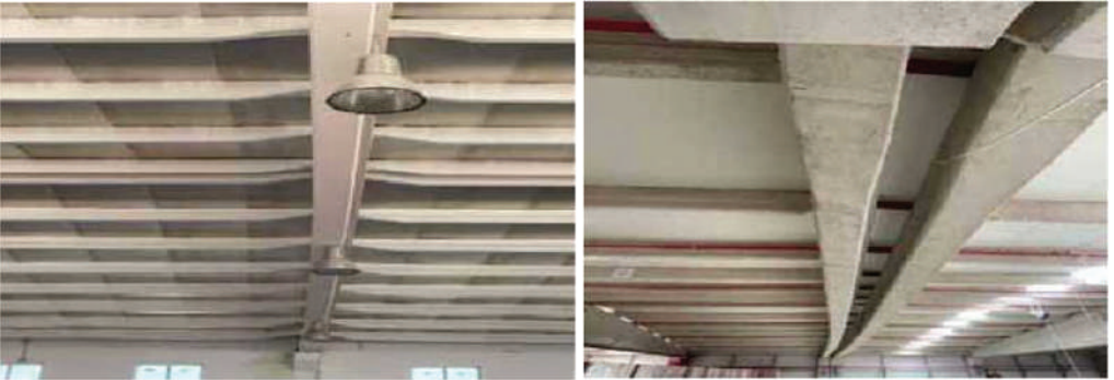
Çatı kirişlerinde yetersiz üst başlık ve yanal sehim
