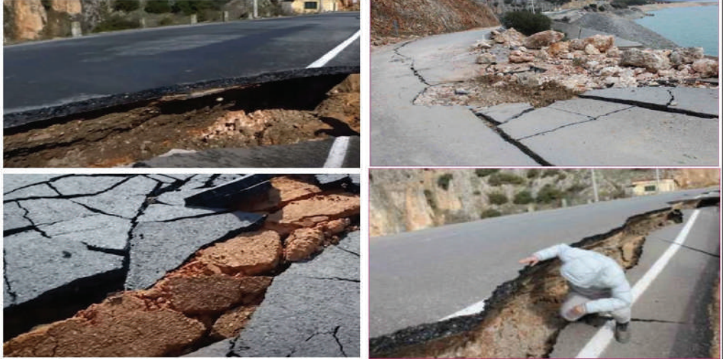
Şekil 6- Kartalkaya barajı gövdesindeki tipik hasarlar
