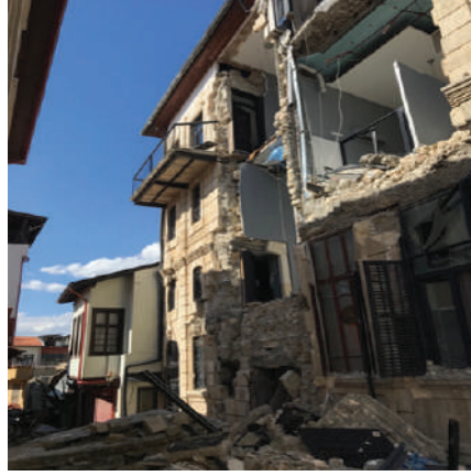
Hatay, Samandağ Vakıflı Köyü'nde düzlem dışı hasarlara örnek; Antakya, Kurtuluş Caddesinde düzlem dışı hasarlara örnek
