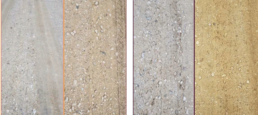
Şekil 44- Pınarbaşı-Bahçelik barajı dolgu kretinde kılcal çatlaklar (aşağı akış bölümü) (sol)
