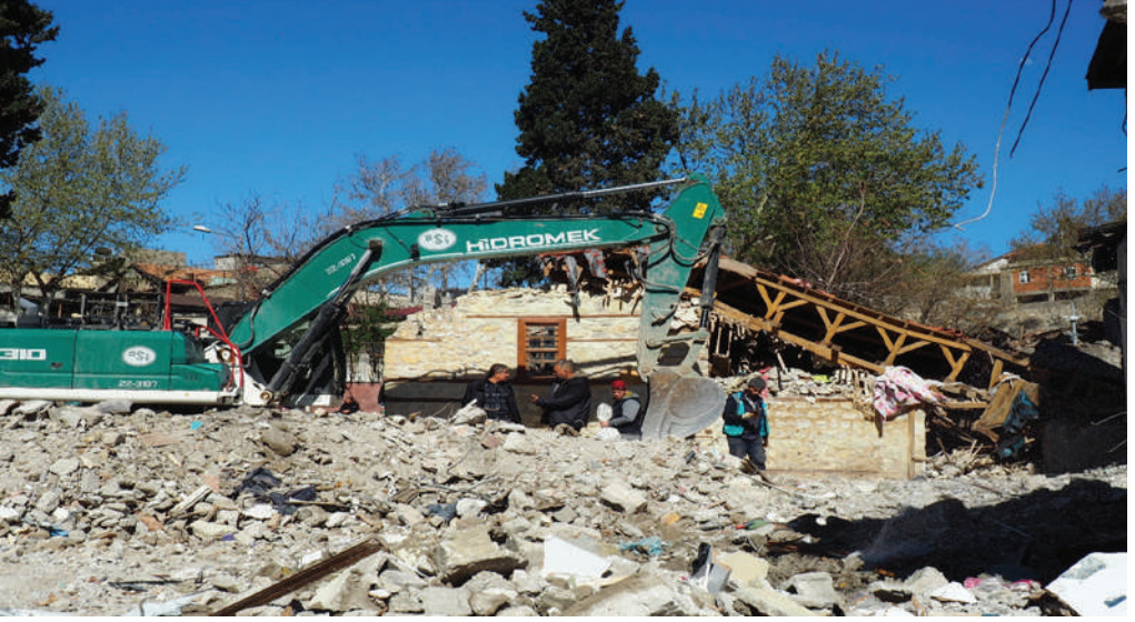
Kahramanmaraş merkez, restore edilmiş ancak ağır hasar almış tarihi yapı
