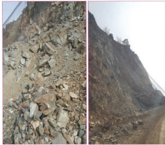
Şekil 24- Kandil barajı bağlantı yollarındaki moloz akmaları (sağ)
