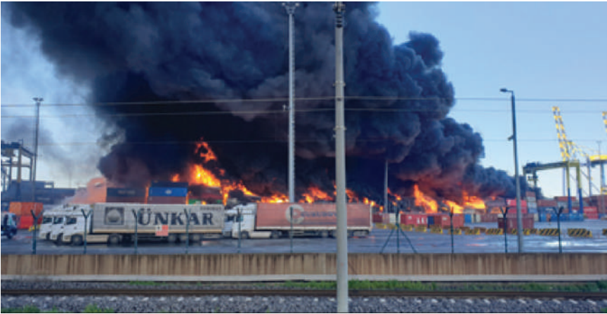
Şekil 65 – İskenderun Limanında yanan konteyner deposu
