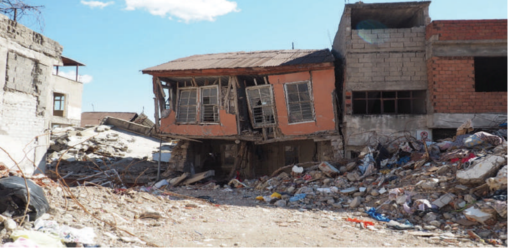
Kahramanmaraş merkez, zemin katı ahşap hatıllı yığma taş, üst katı ahşap karkas yapı
