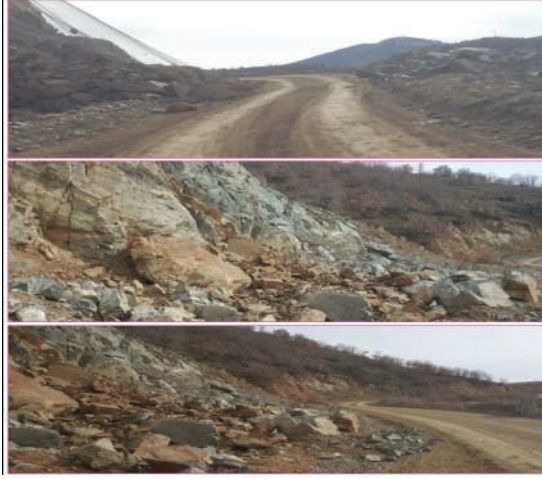
Şekil 23- Kandil barajı bağlantı yollarındaki kaya düşmeleri (sol)
