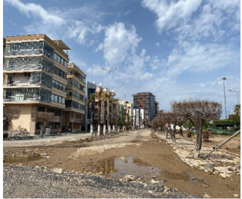
Şekil 7: İskenderun Balıkçı Barınağı ve arkasındaki bölgede kıyı çökmesi ve çöken alanda su birikmesi
