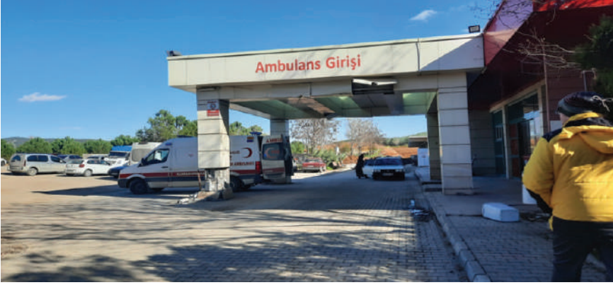
Kahramanmaraş Şehir Hastanesi
