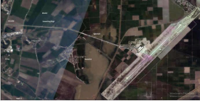
Şekil 61 – Hatay Havalimanı ve bağlantı yolunun uydu görüntüsü
