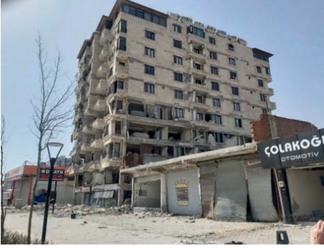
Antakya'da hasar görmüş ancak ayakta kalmış bina.
