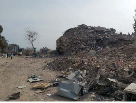
Trabzon Bulvarında yolun bir tarafında enkaz haline dönüşmüş binalar, diğer tarafında ise yönetmeliğe uygun inşa edilmiş ve ayakta kalmış binalar görülmekte.
