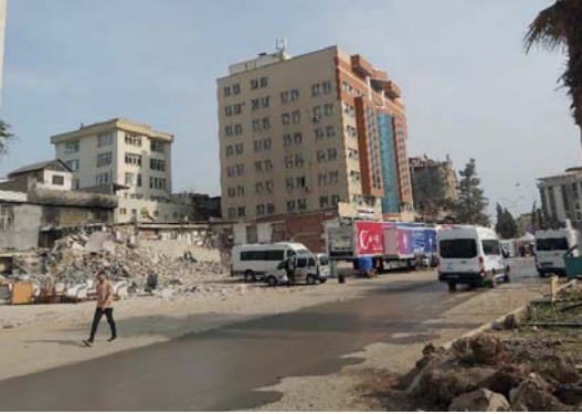
Trabzon Bulvarında yolun bir tarafında enkaz haline dönüşmüş binalar, diğer tarafında ise yönetmeliğe uygun inşa edilmiş ve ayakta kalmış binalar görülmekte.
