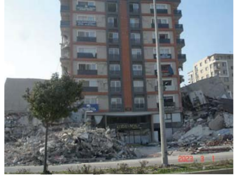
Antakya'da iki yanındaki binalar yıkılmışken ayakta kalmış bir bina
