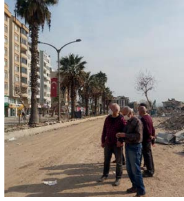
Trabzon Bulvarında yolun bir tarafında enkaz haline dönüşmüş binalar, diğer tarafında ise yönetmeliğe uygun inşa edilmiş ve ayakta kalmış binalar görülmekte.
