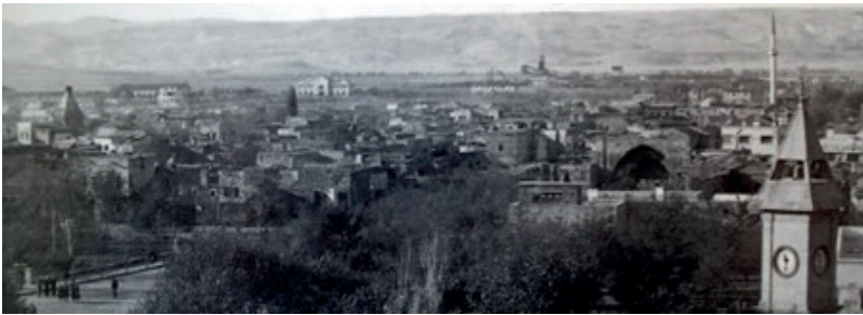
1940 başları Kayseri kent merkezi ve arka planda Sümerbank Kayseri Fabrikası (Fotoğraflarla Kayseri 1880-2006, Kocasinan Belediyesi, 2006)
