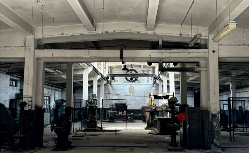
Susukun makineler, bakım onarım atölyesi
